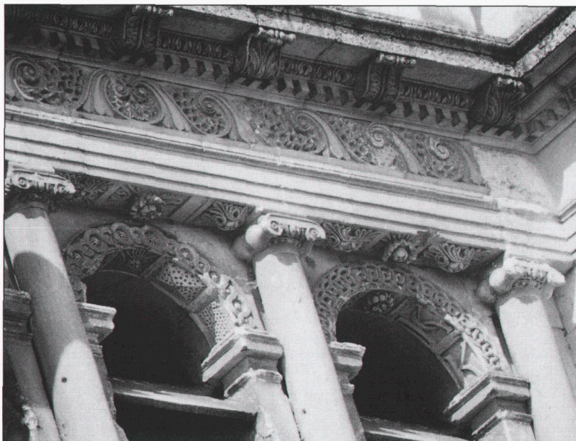
Fig. 4 : Détail de l'élévation de la face est, au 1 er étage : ordre ionique (Cliché C. Corvisier).
