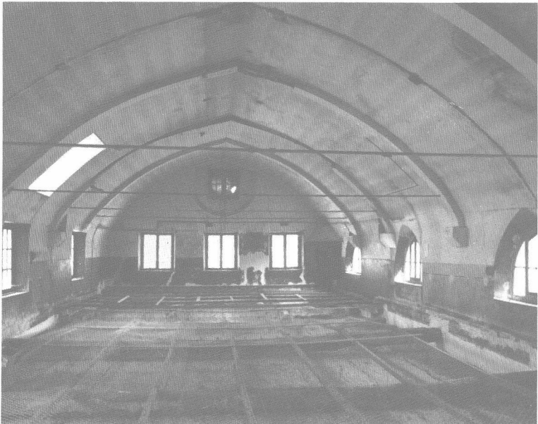
État de la chapelle des Capucins en 1991.
